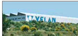
Lisbon, Portugal Velan Válvulas Industriais, Lda.
